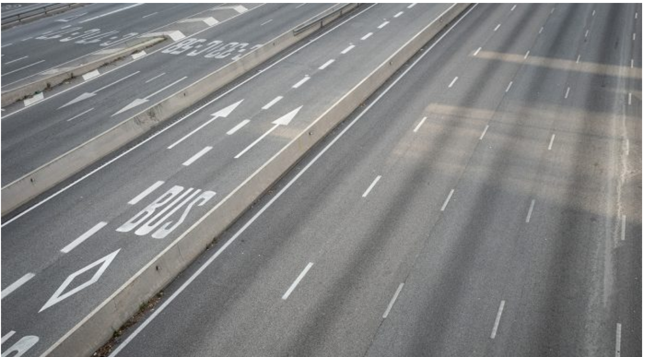
Meridiana, al sud del Pont de Sarajevo. 28 de març.
